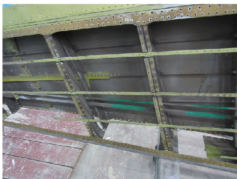
Рис.7. Повреждения внутреннего силового набора левого стабилизатора. Селективная коррозия: глубина повреждений 0,3...0,6 мм, материал Д16Т, толщина 1,0 мм
