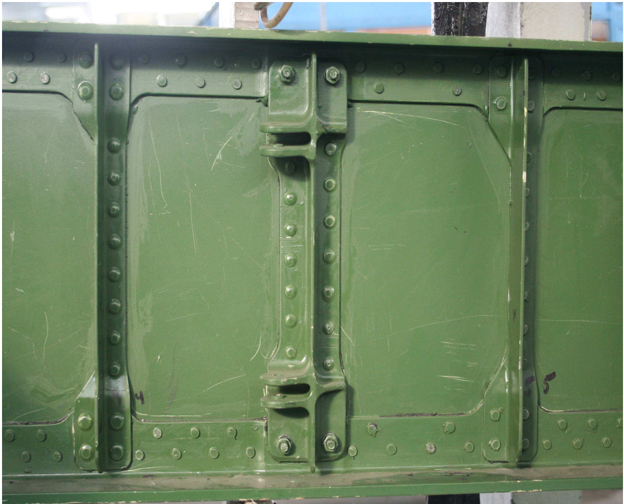
Рис. 7. Участок лонжерона в зоне установки подкрепляющих стоек
